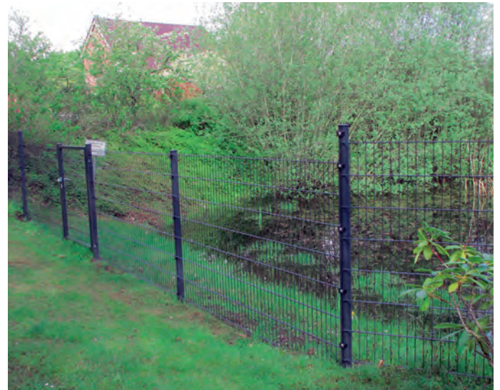
Aus Sicherheitsgründen musste das Regenwasserrückhaltebecken am Ehrenmal mit einem Zaun eingefriedigt werden.
